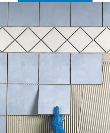
A burkolólapok helyzete utánigazítható 60 percen belül
