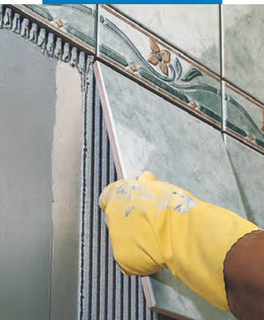
Egyszer égetett burkolólap ragasztása vakolatra
