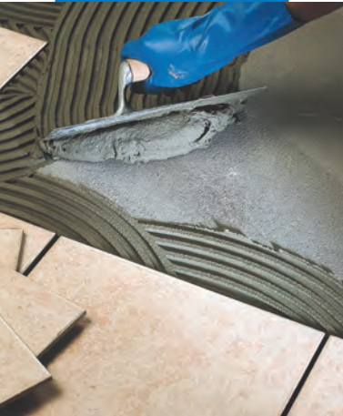
Egyszer égetett burkolólap ragasztása padlóra
