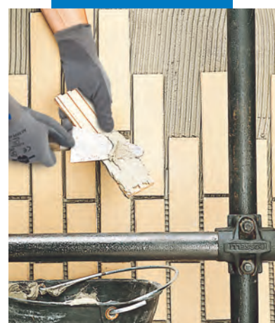
Szalagcsempe ragasztása homlokzatra. Megjegyzés: a hátoldal bordázatait teljesen töltsé ki
