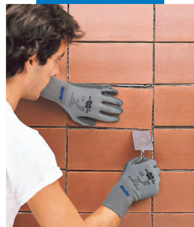
Burkolólapok ragasztása meglévő burkolólapokra szürke Adesilex P9-cel
